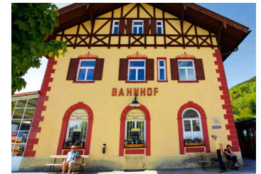
Endlich sichtbar: Regionalbahnhöfe
